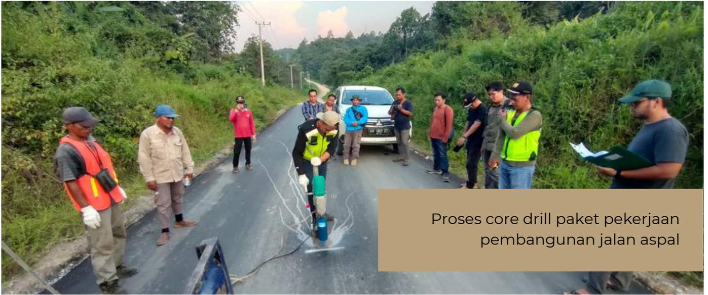
Proses core drill paket pekerjaan pembangunan jalan aspal
